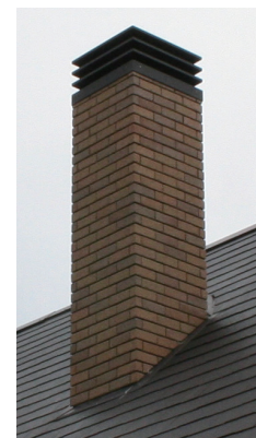
煙突囲い頂部の雨仕舞いと排気トップを兼用する風雨に強い施工例です。煙突囲いの仕上げ材料は建物の外観に合わせた素材をお選びください。
