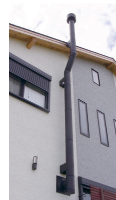
壁出し工事の場合、壁に施工された不燃材のメガネ石に断熱二重煙突を貫通させます。外壁への煙突設置は自在式サポートですっきりと仕上がります。
