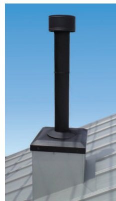
ガルバリウム鋼板屋根の場合、屋根材と煙突部材との電触による腐食を避けるため、煙突囲いの設置工事をする必要があります。
