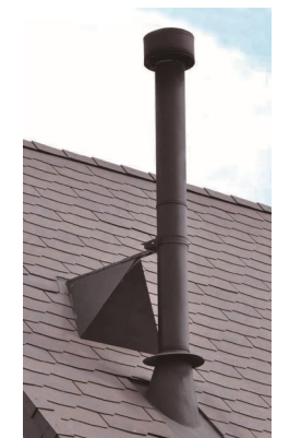
雪の多い地域での施工例です。雪割りとサポートを兼ねた部材で煙突をしっかり支えます。屋根勾配に合わせた調整も可能です。
