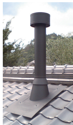
日本瓦や洋瓦の屋根貫通工事は瓦屋根用フラッシングで美しく仕上げることができます。瓦屋根でもしっかりとした水切り施工が可能です。
